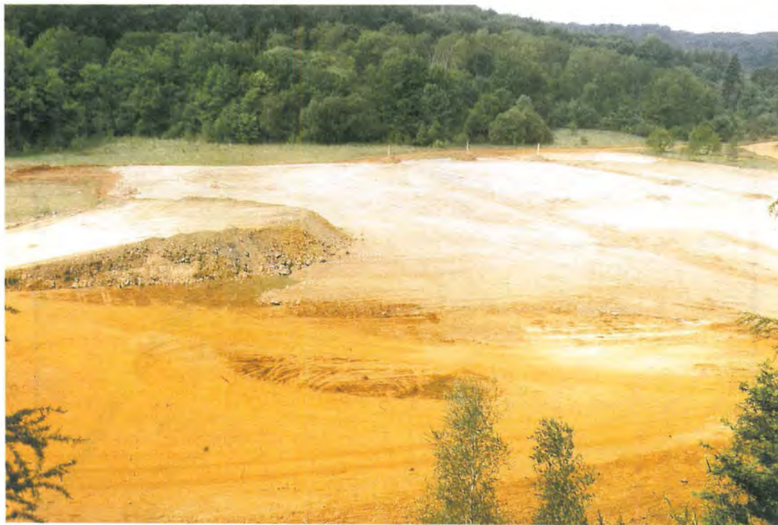
Photo 21: Le puits du site Eisekaul remblayé quelques semaines après son apparition (A. Storoni, mai 1998)
