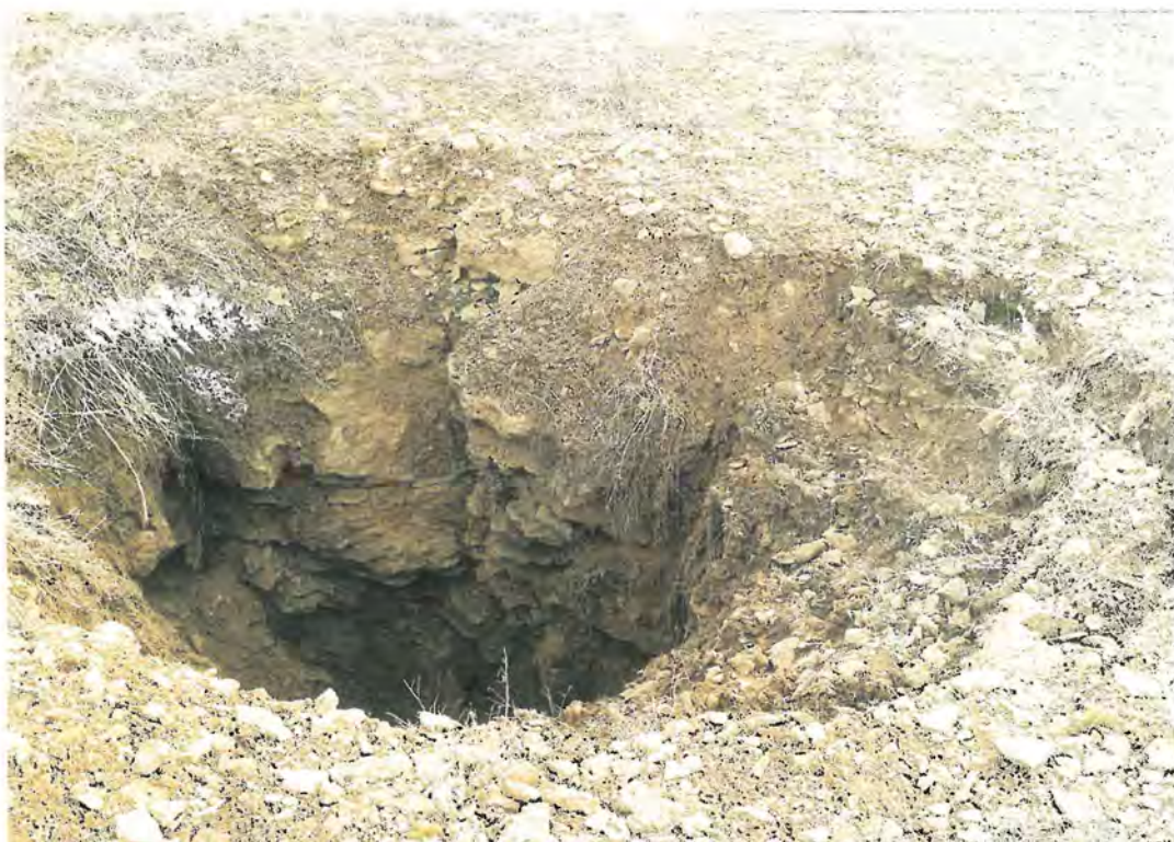
Photo 8: Terrassettes de glissement sur un des versants de l'entonnoir n° 7 du site Longues Raies (A. Storoni, janvier 2000) La photo a été prise du NE vers le SW, à l'endroit de la coupe a (fig. 68).
