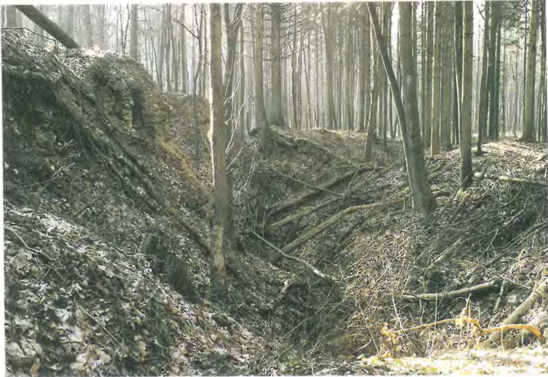
Photo 6: La crevasse du site Pellestack (A.Storoni, février 1999)
