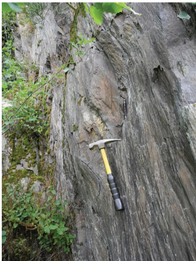
Photo 1 : Ancienne carrière de l'ardoisière d'Emeschbaach. Dans le phyllade ardoisier appartenant au Membre de Martelange, présence d'une lentille de grès traversée par une veine de quartz laiteux d'allure sigmoïdale.
