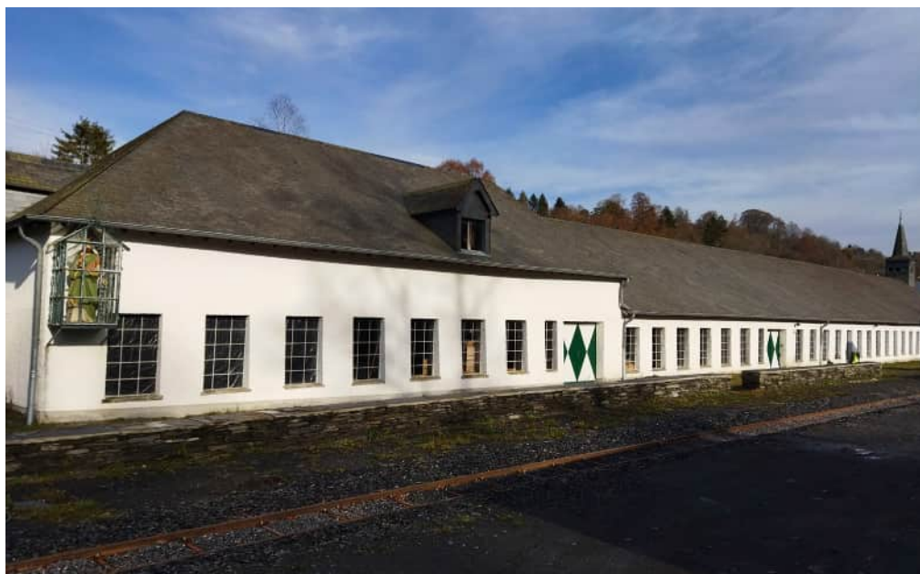
Photo 28 : Haut-Martelange, point E231. Site de l'ancienne ardoisière de Haut-Martelange, photographié le 10 novembre 2021. Atelier des fendeurs de la carrière Johanna reconverti en espace muséologique. A l'angle du bâtiment du côté gauche, présentoir de sainte Barbe, patronne des mineurs.
