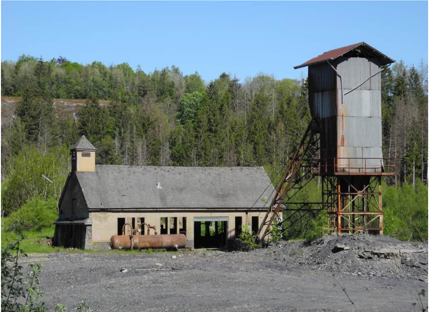
Photo 20 : Chevalement et bâtiment vestiges de l'exploitation ardoisière Adolf sur le site de Martelange-Rombach (situation juin 2021).
