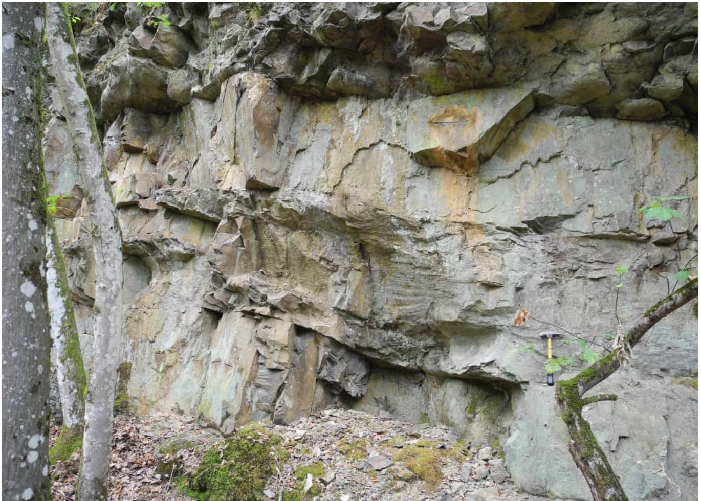
Photo 10 : Eschdorf, point E105. Formation de l'Our, Membre de Stolzenbourg. Dans une ancienne carrière à l'ouest d'Eschdorf, les niveaux à pseudonodules ont été exploités avec les bancs de grès voisins. Photographie des deux niveaux à pseudonodules (l'inférieur, à hauteur du marteau, le supérieur, dont on ne voit que la base, au sommet de la photo). Le marteau mesure 35 cm de long.
