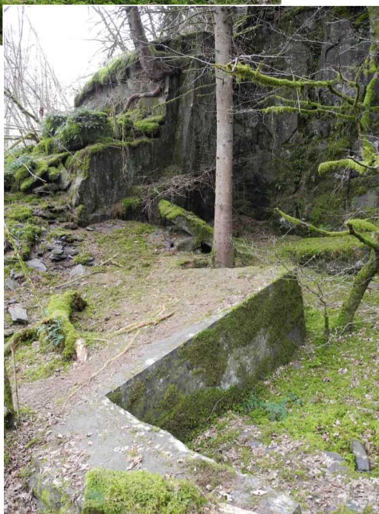
Photo 23 : Bilsdorf, point E409. Ancienne carrière au lieu-dit Neimillen. Photo prise le 29 mars 2022 vers le nord. Découpage parallélépipédique de la roche.
